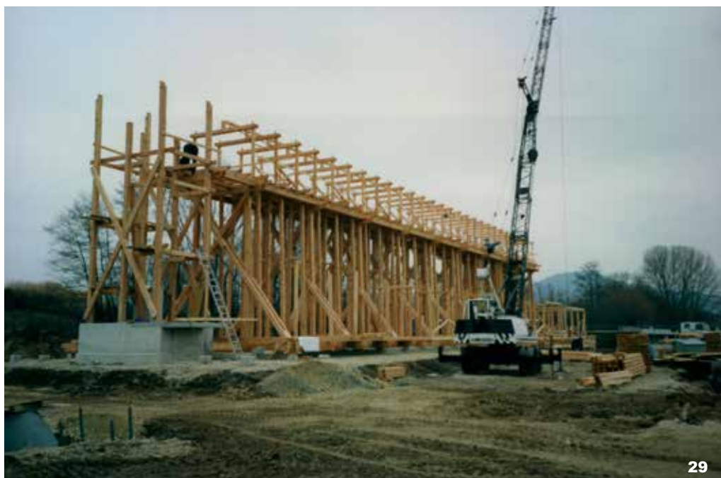
Die Anlage des Kurparks 1998: Gerüst eines der beiden Gradierwerke.
