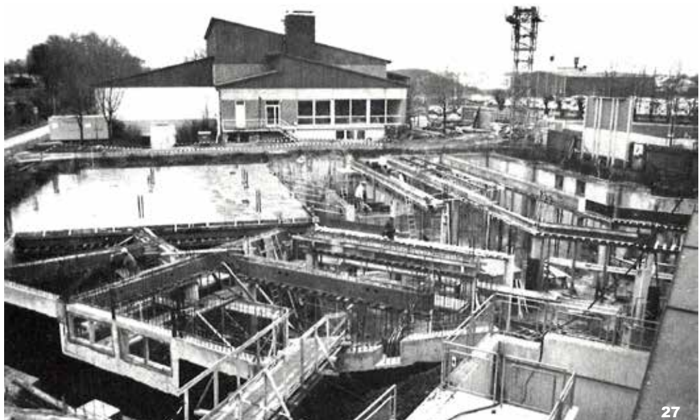
Baustelle des Kurmittelhauses im Januar 1988.
